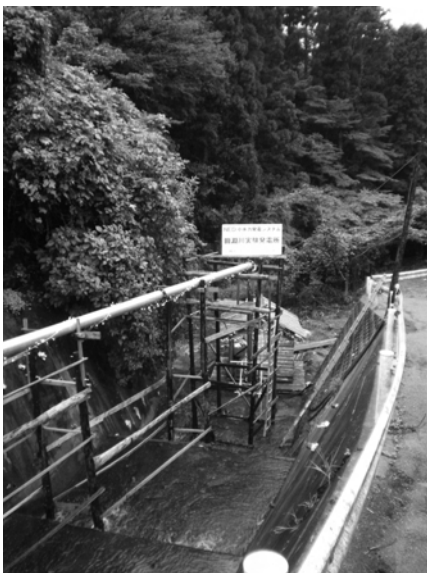
小水力発電システム公開実験 9/20~11/20 市原市田淵地先 詳しくは、当社ホームページ http://nedkof.co.jp
